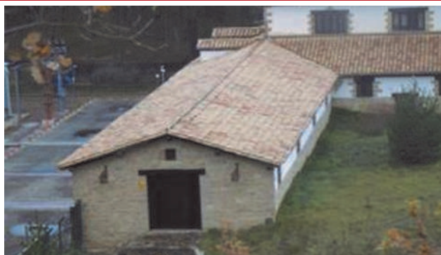
Aspecto de la subestación de Codés.
