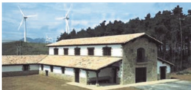
Aspecto de la subestación de Codés.
