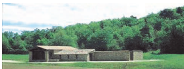
Conjunto de la subestación de Ibargoiti.
