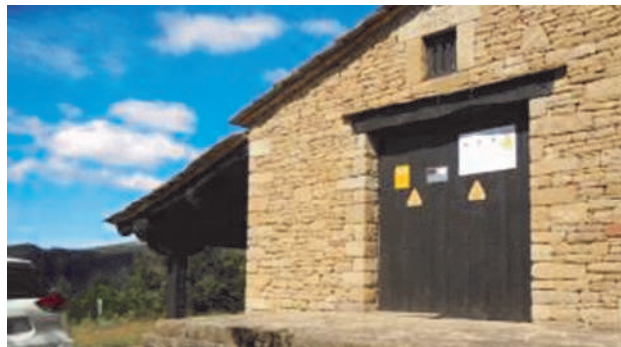
Fachada sur de la subestación de Alaiz.
