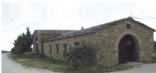
Trasera de la subestación de Izco.
