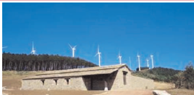
Vista general de la subestación de Alaiz.
