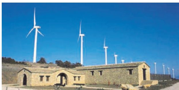
Conjunto de la subestación de Izco con el parque detrás.
