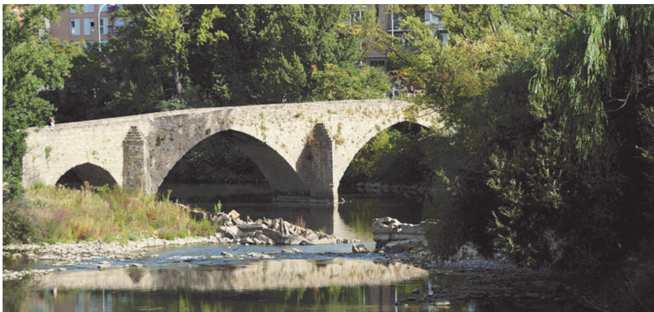
Puente de Santa Engracia, al fondo, y el azud, la presa, en su estado actual. Imagen del autor.
