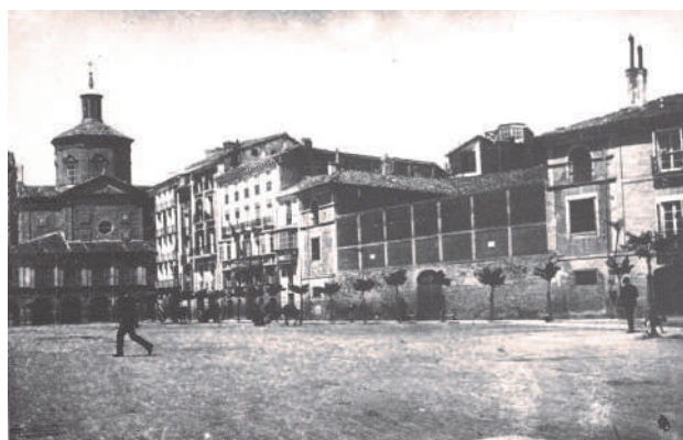
Fachada trasera del palacio de Amendáriz y edificio de la aduana. José Joaquín Arazuri, "Pamplona, calles y barrios".
