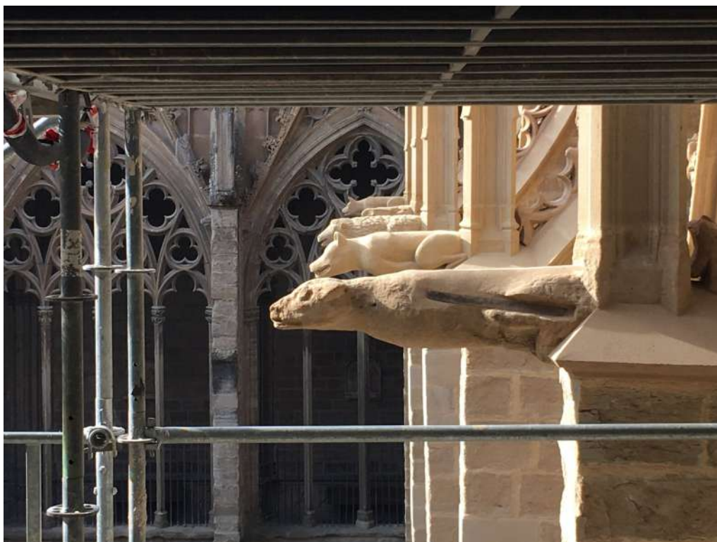
Restauración y reposición de gárgolas.
