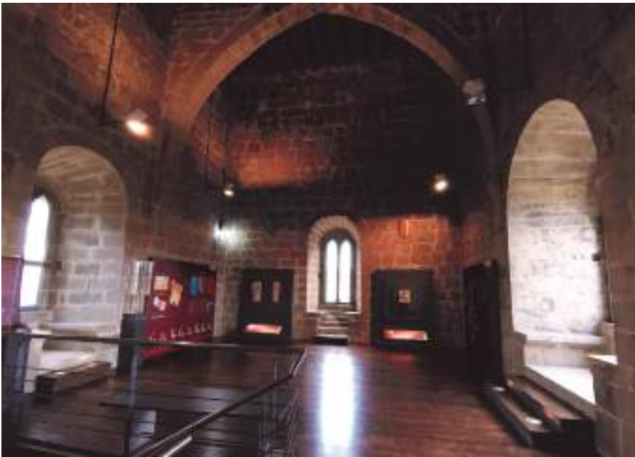
Vista actual del interior.
