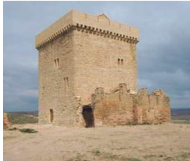
La torre después de la restauración. Restos de la capilla anexa.
