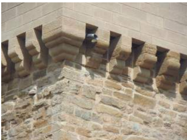
Matacanes vistos desde el exterior.
