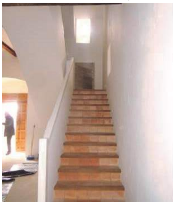
Escalera de subida a la primera planta.
