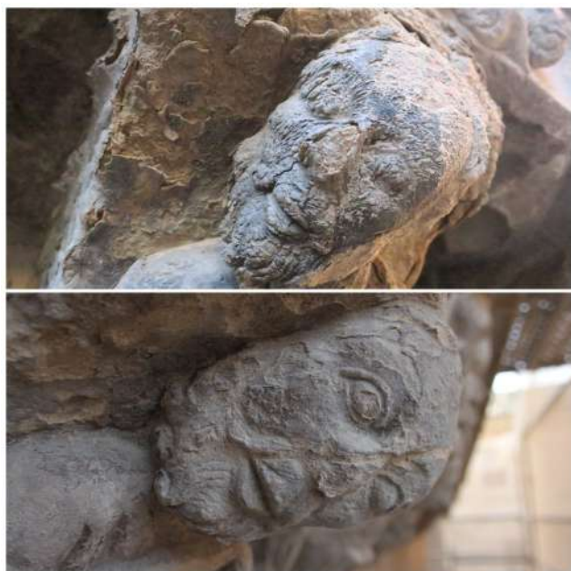
Figura de un canecillo de la cornisa superior. Antes y después de la restauración, se observa la costra que deformaba la labra.
