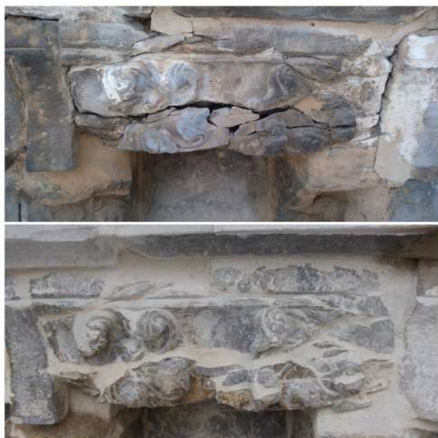
Sillar con numerosas fracturas, alteración habitual de la caliza campanil, antes y después de la restauración.
