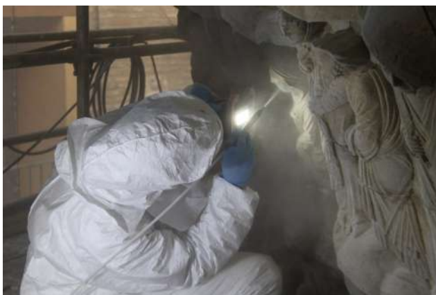
Limpieza de las arquivoltas con microproyección de abrasivo.
