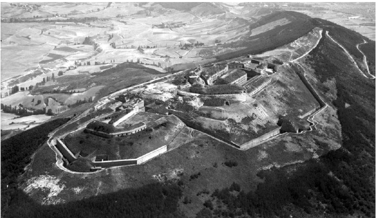
Fotografía aérea de la totalidad del fuerte a la finalización de las obras, en 1920.
