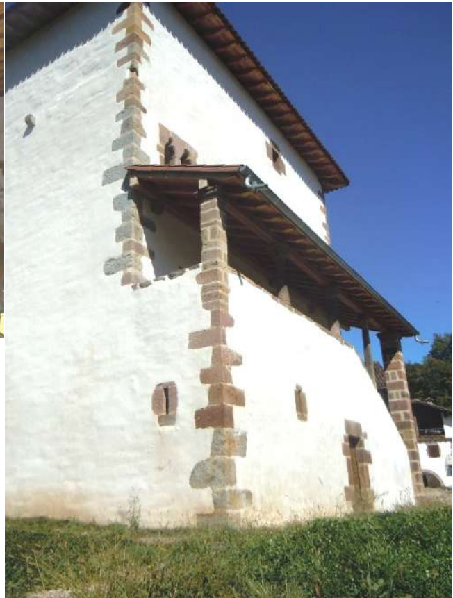
Escalera exterior de acceso a la 1ª planta.
