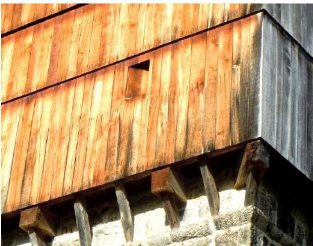
Detalle del exterior con los apoyos de la pared de madera.
