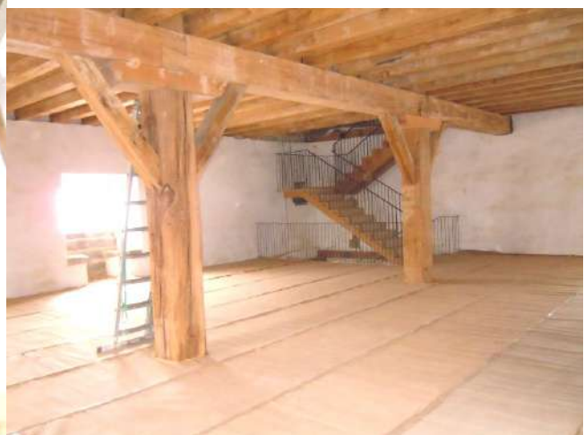
Planta 2ª: vigas del techo apoyadas en muros.
