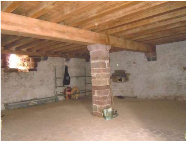
Planta baja, con vigas apoyadas en modillones de piedra empotrados en la pared.
