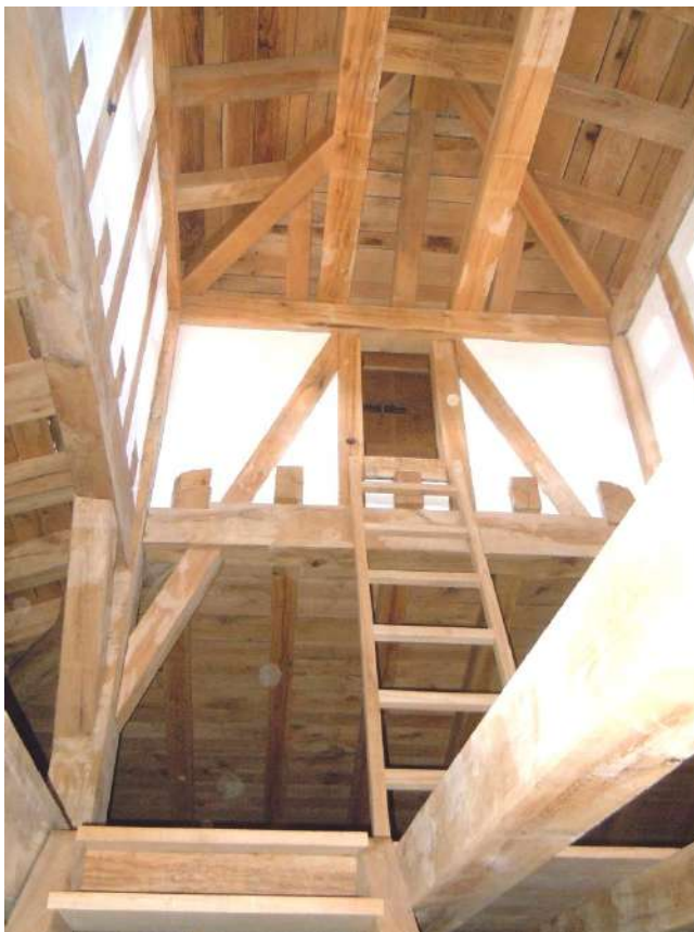
Estructura de madera de la 3ª planta con el lucernario.
