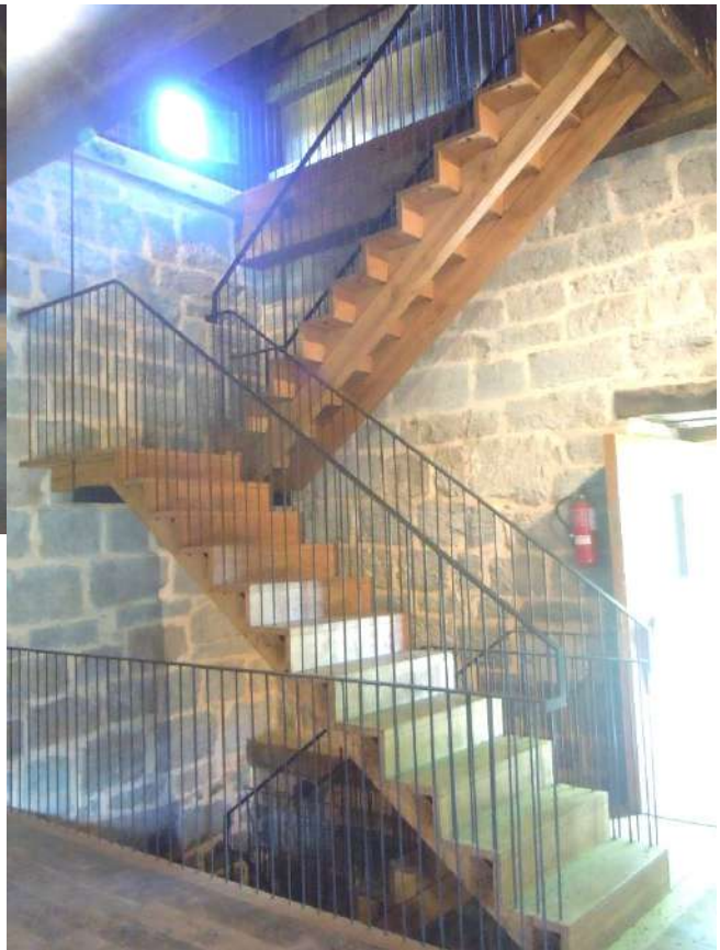
Los extremos intermedios de los dos tramos se apoyan en una viga metálica colgada.
