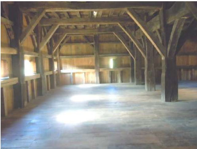
Planta segunda con pilares de madera.
