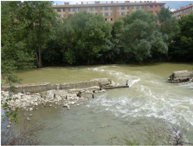
Vista de la presa y los acarreos de aguas arriba.
