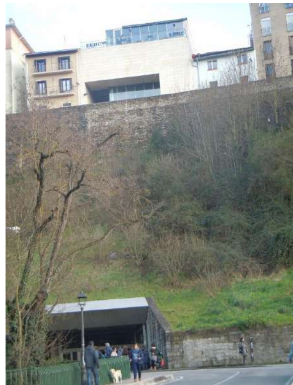
Edificio superior del ascensor de Descalzos y entrada inferior
