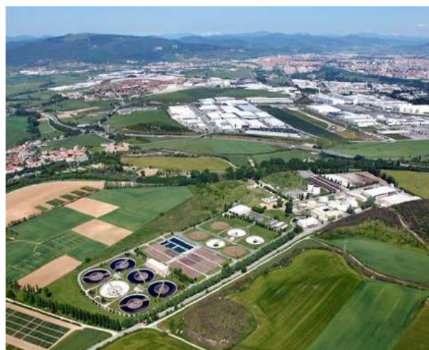
Vista aérea de la Depuradora de Arazuri en un meandro del río
