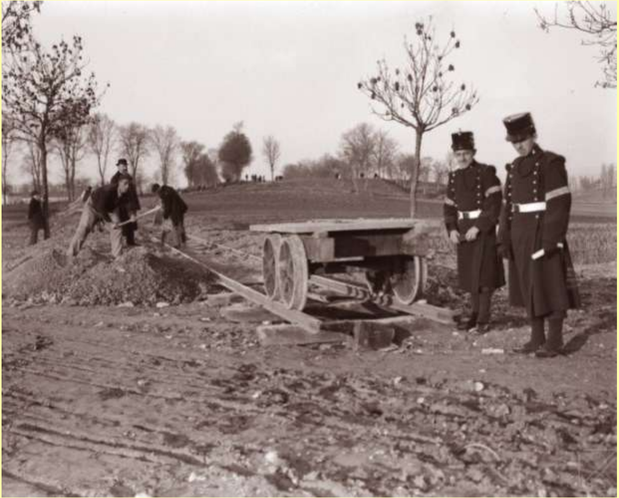
Obras del tendido de la vía en las proximidades de Jurizmendi, cerca de Vitoria, el 8 de septiembre de 1919. Fotografía: E. Guinea, Archivo Municipal de Vitoria Gasteiz.
